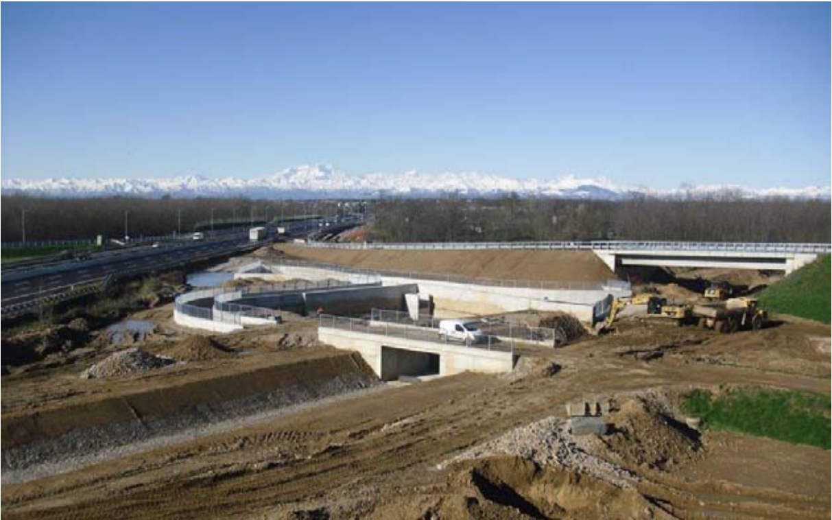
Tratta A - Rampa Cava Gasparoli
