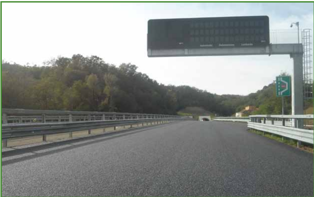
TGVA - Imbocco Galleria Naturale di Morazzone lato Gazzada Schianno
