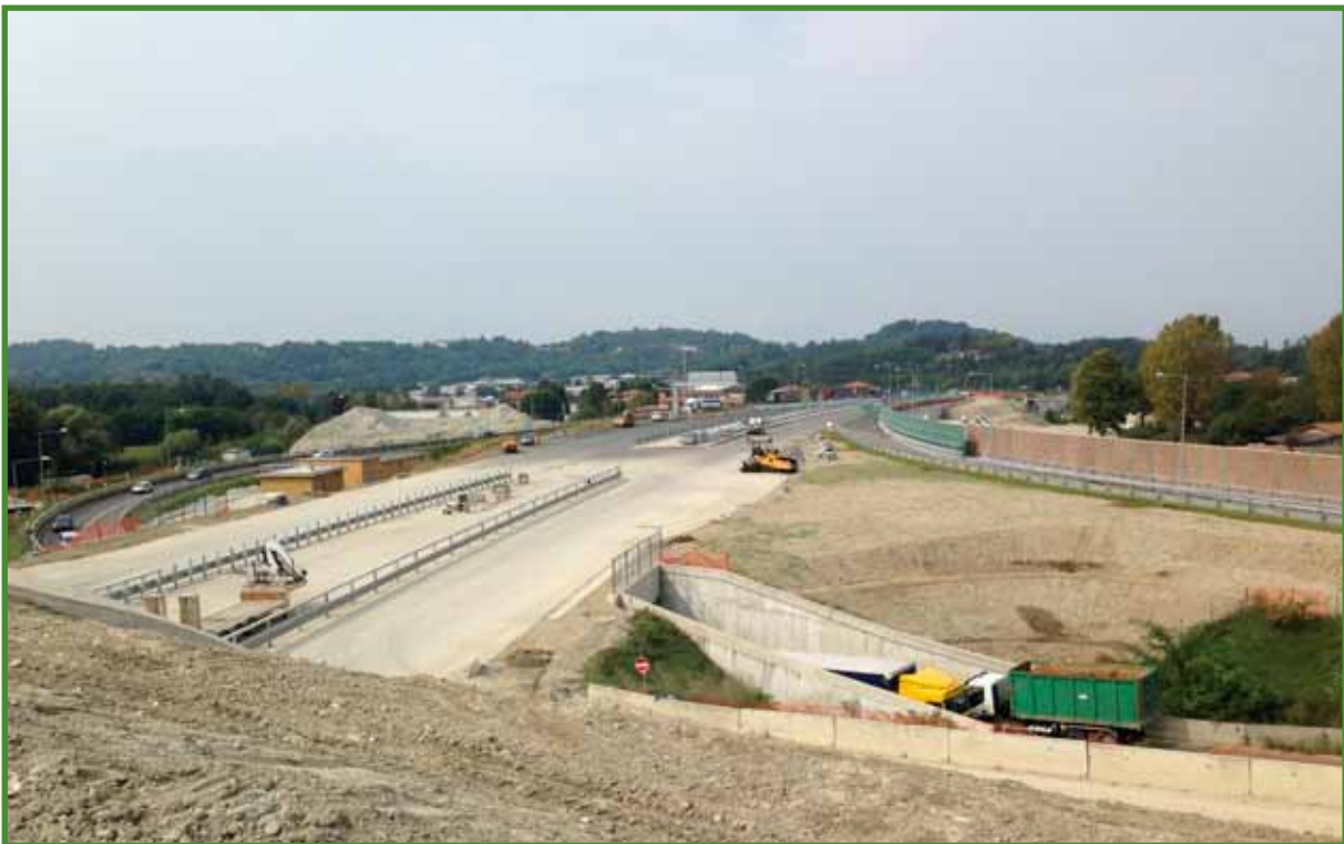
TGVA - Rilevato in direzione svincolo di Gazzada A8
