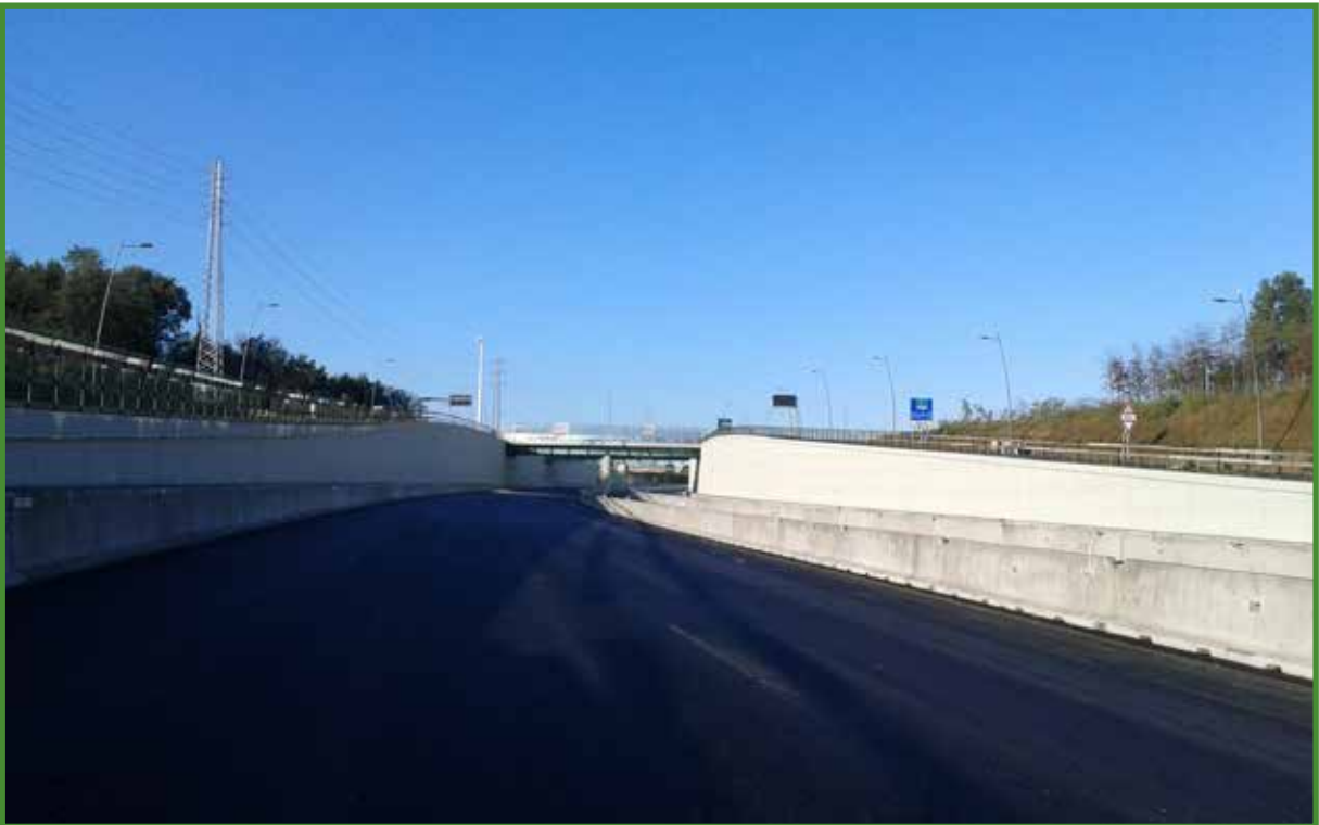
Tratta B1 - Carreggiata est svincolo Lazzate
