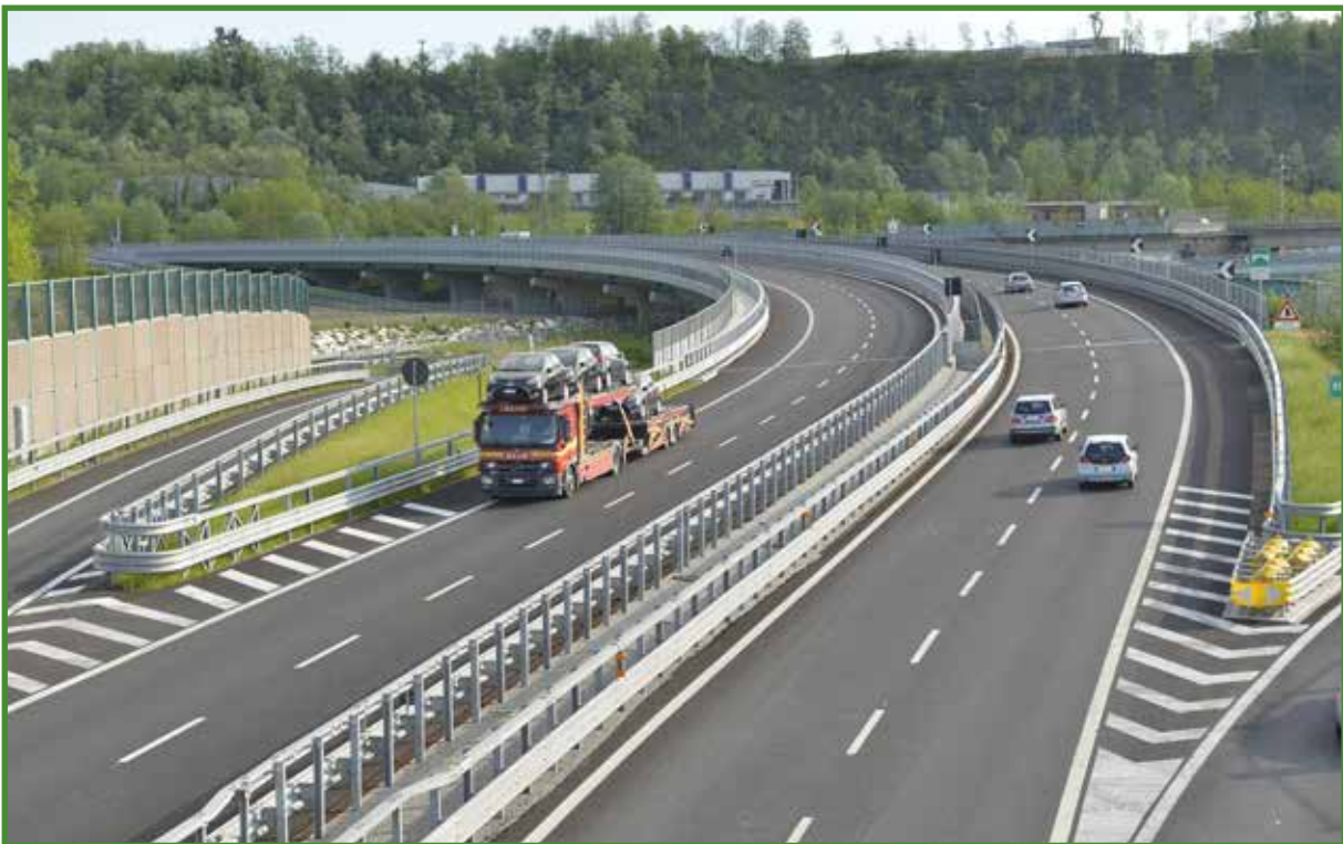
TGVA1 - Svincolo di Vedano Olona
