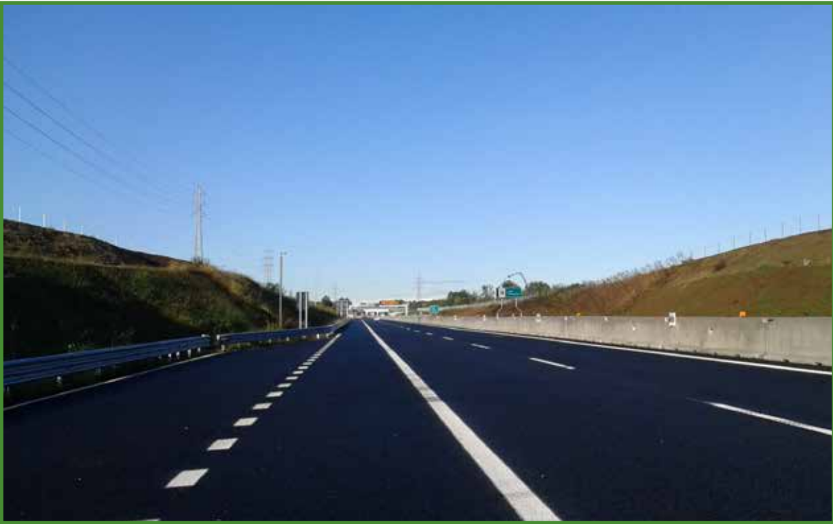
Tratta B1 - Carreggiata est prossimità viadotto Lura
