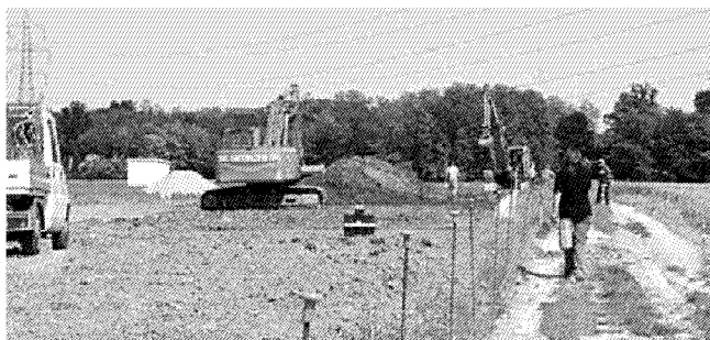
Ruspe in azione sui campi che verranno attraversati dall'autostrada (foto Mv)
