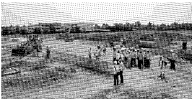
All'opera | lavori per il viadotto di Cassano Magnago
