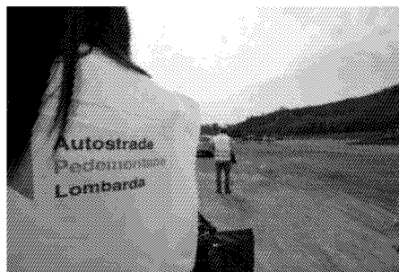
AUTOSTRADA I cantieri della Pedemontana
