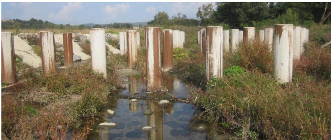
**Figura 10 – struttura di trattenuta del materiale grossolano realizzata sul Seveso**
