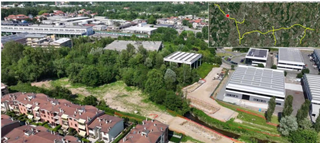
PONTE DI VIA PRATI, TRA MEDA E BARLASSINA
