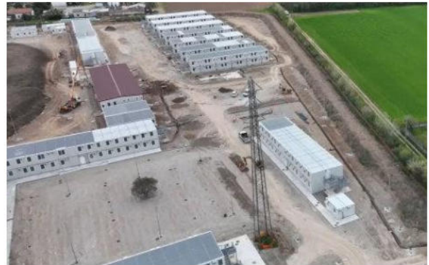
LAVORI DI REALIZZAZIONE DEL CAMPO BASE A DESIO
