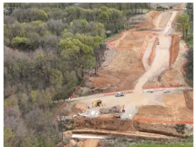
ATTIVITÀ DI SCAVO DELLA GALLERIA ARCORE 2
