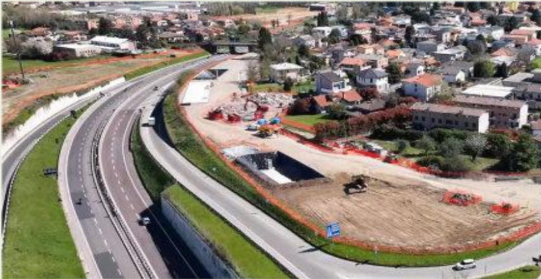
CANTIERIZZAZIONE RAMPA PISTA A SVINCOLO DI LENTATE.
