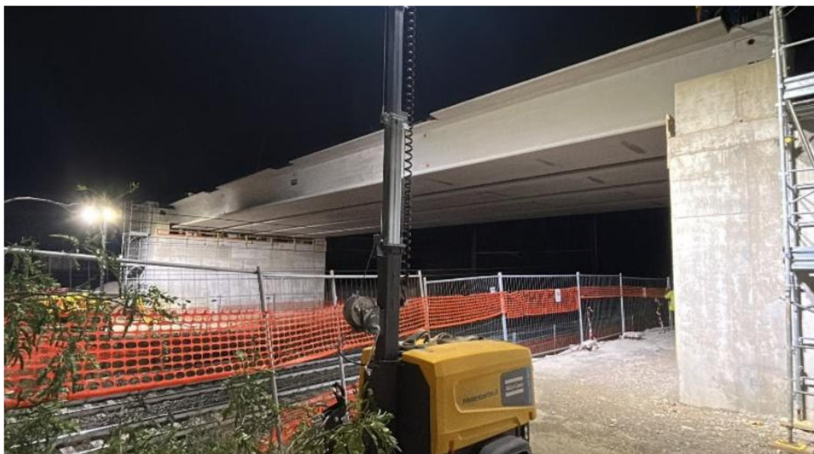
VARO DELLE TRAVI SULLA LINEA FERROVIARIA COMO-CHIASO
