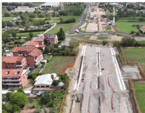
GALLERIA ARTIFICIALE DESIO: REALIZZAZIONE CORDOLI DI TESTA
