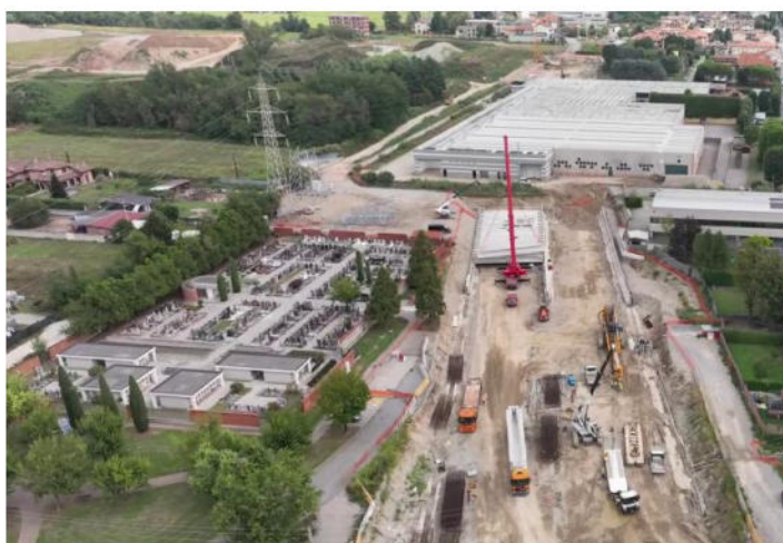
GALLERIA ARTIFICIALE MACHERIO 1: IN CORSO POSA TRAVI PREFABBRICATE DI COPERTURA
