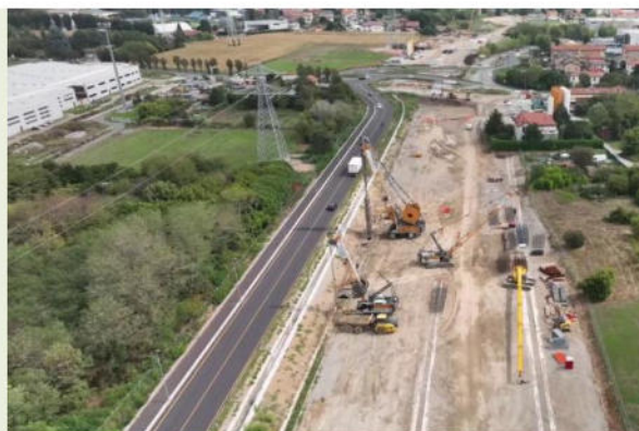
GALLERIA ARTIFICIALE DESIO: IN CORSO REALIZZAZIONE DEI DIAFRAMMI CON IDROFRESA
