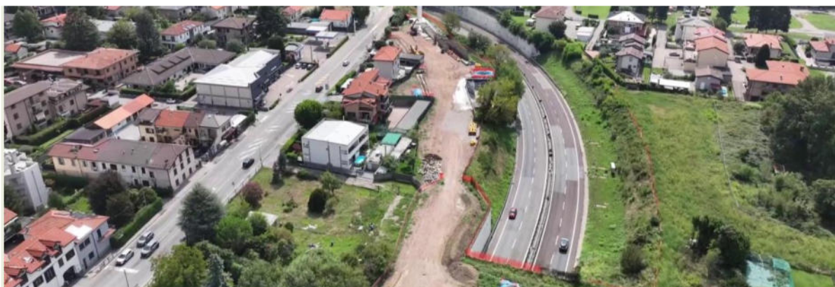
REALIZZAZIONE CORDOLI GUIDA PER DIAFRAMMI DEL MURO 47
