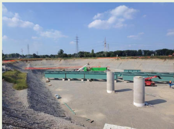
CAVALCAVIA DESIO 1 MONTAGGIO IMPALCATI METALLICI
