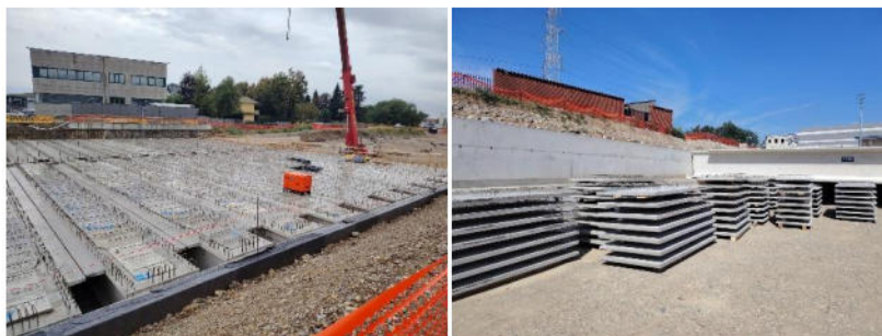
GALLERIA MACHERIO 1 POSA IN OPERA TRAVI E PREDALLES
