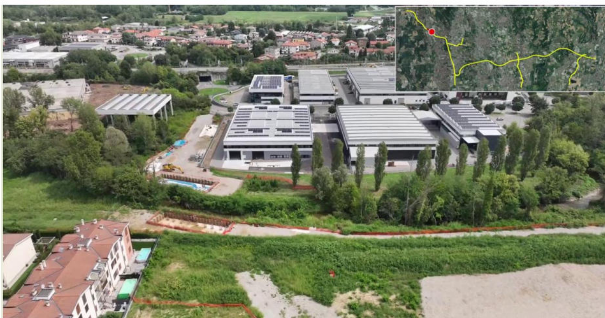
BARLASSINA - REALIZZAZIONE FONDAZIONI SPALLE PONTE VIA PRATI
