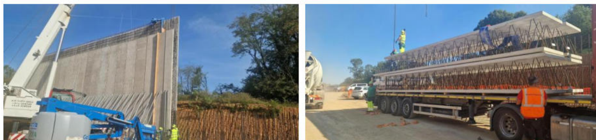
GALLERIA ARTIFICIALE ARCORE 1 - POSA IN OPERA DELLE BILASTRE
