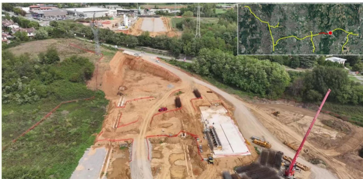
GALLERIA ARTIFICIALE LESMO 2: SONO STATE AVVIATE LE PRIME ATTIVITÀ DI REALIZZAZIONE DEI DIAFRAMMI DI GALLERIA
