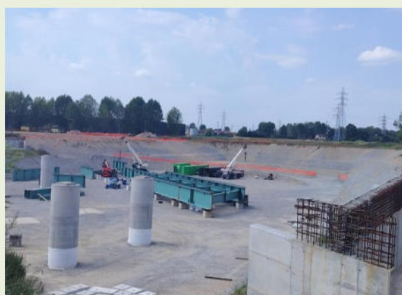
CAVALCAVIA DESIO 1 MONTAGGIO IMPALCATI METALLICI
